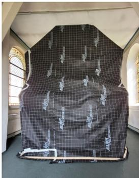
Parallel dazu wurden Orgel, Altar und Kanzel „eingehaust“, um sie vor Staub und Schmutz zu schützen. Elektrische Leitungen wurden in Kabelschächten verlegt, damit die vorgesehenen Bankheizungen angeschlossen werden können. Neue Pendelleuchten sowie ein ausgearbeitetes Lichtkonzept für die Beleuchtung des Altars und der Kirche sollen umgesetzt und Mikrofon-, Lautsprecher- sowie Videoübertragungsanlage überarbeitet werden.
